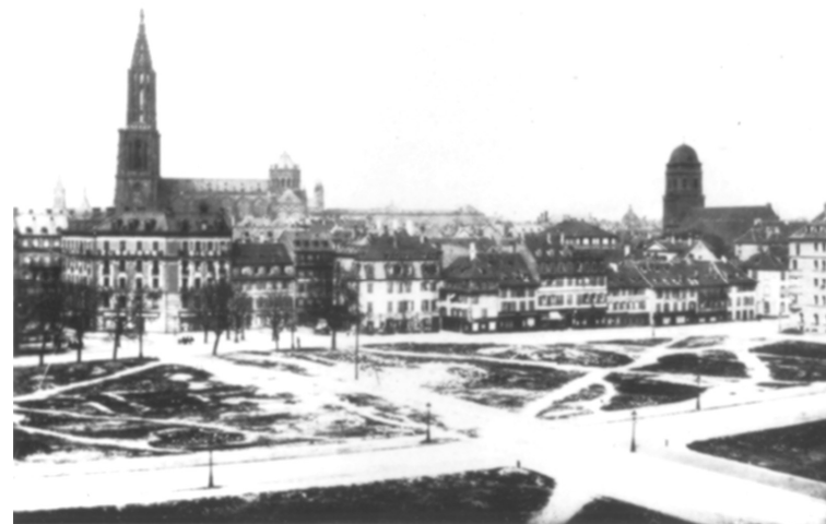
4. Démolition des casernes (au premier plan la rue de Soleure)
